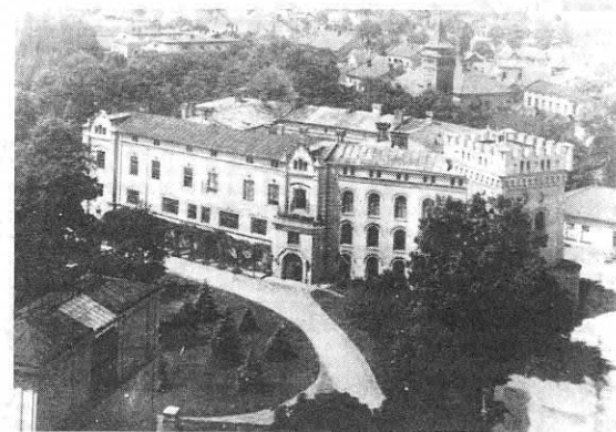
Stary zamek – po przebudowach z czasów Habsburgów
